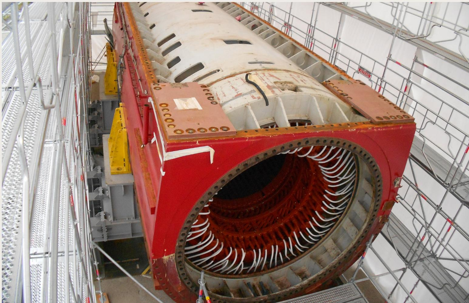
Opération de déconstruction de rotors et stator centrale nucléaire du Bugey 5
