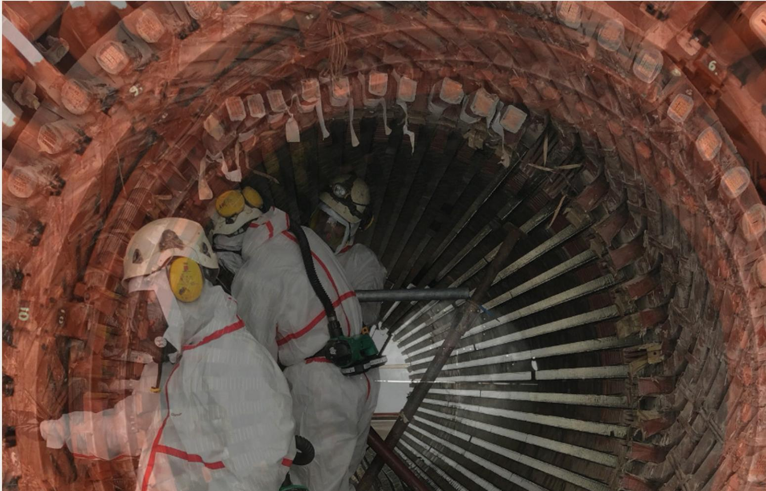
Désamiantage et déconstruction d'un stator : Centrale nucléaire du Bugey 3
